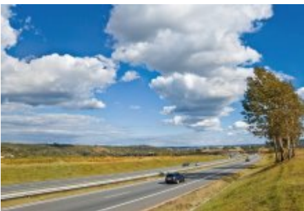
• Stalexport Autostrada Małopolska S.A.
