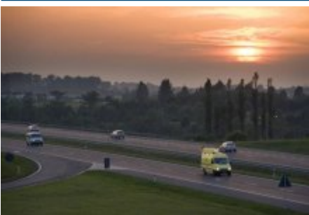
• Stalexport Autostrada Małopolska S.A.
