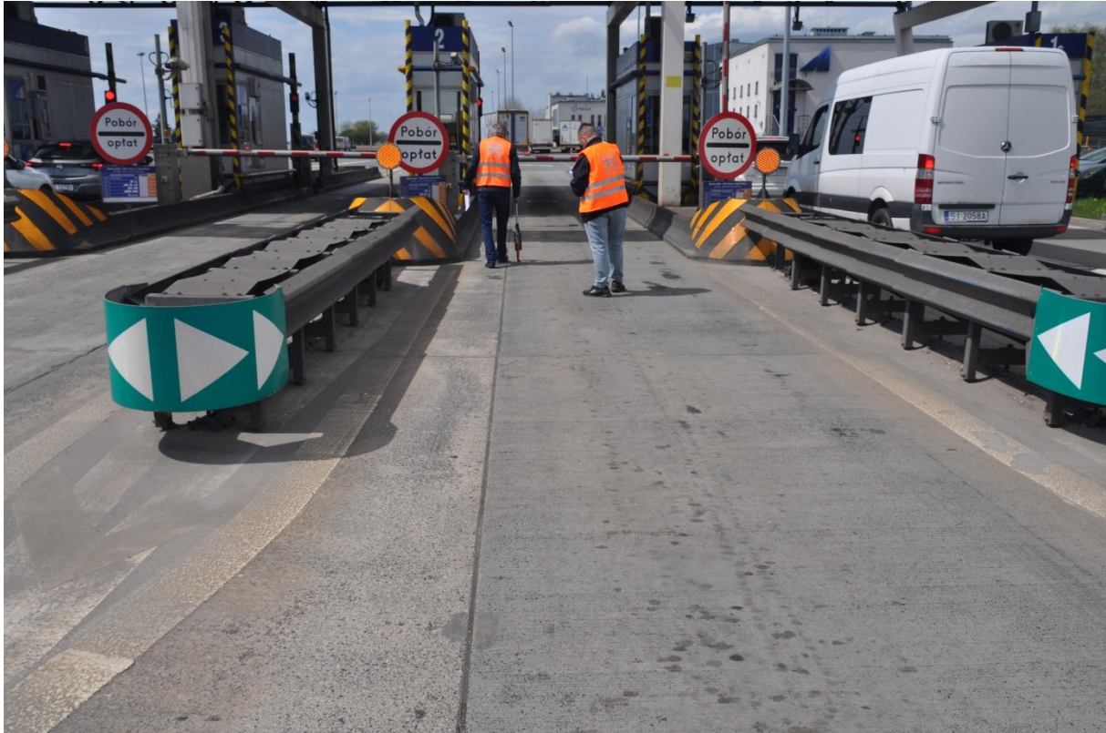
Zdj. 12 Widok ogólny nawierzchni betonowej na linii 2
