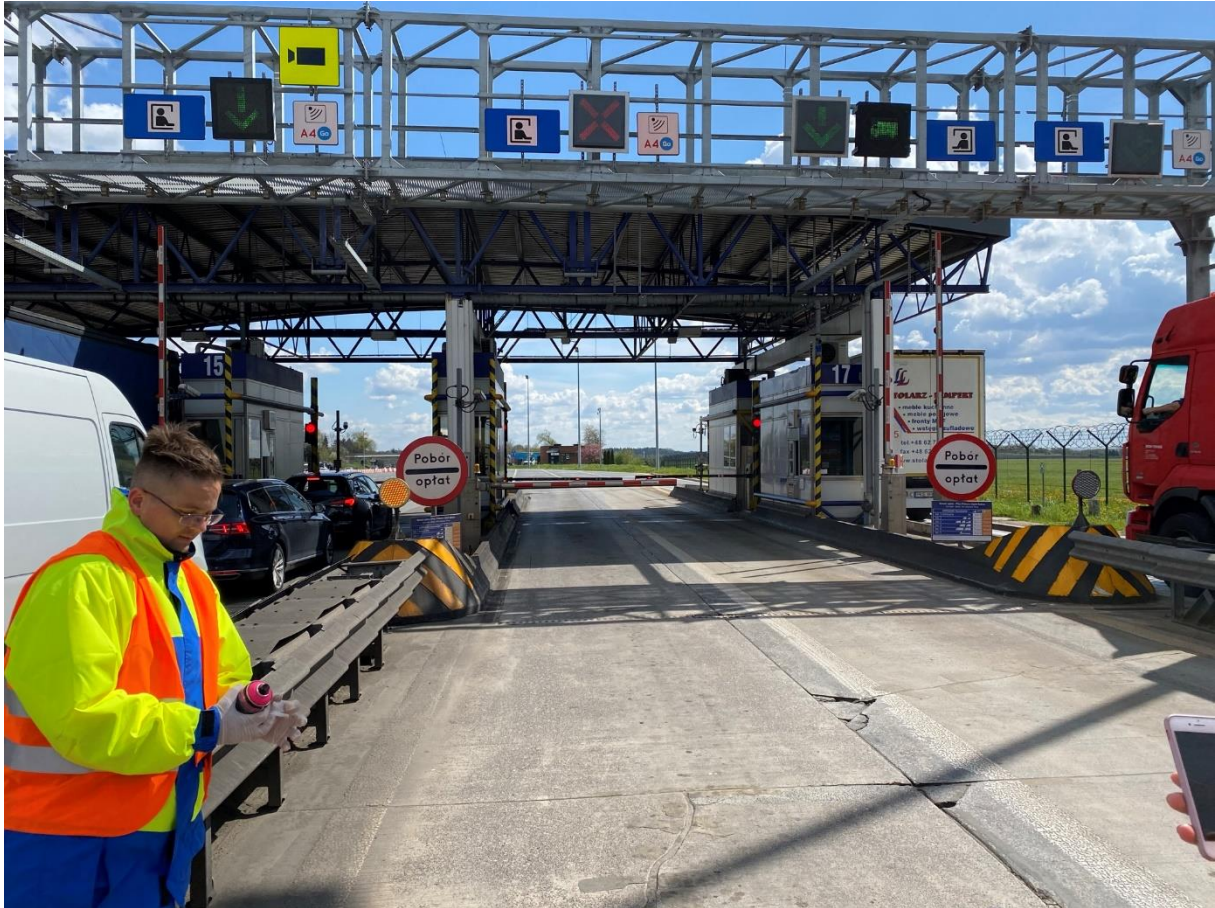
Zdj. 118 Widok ogólny nawierzchni betonowej na linii 16 i 17
