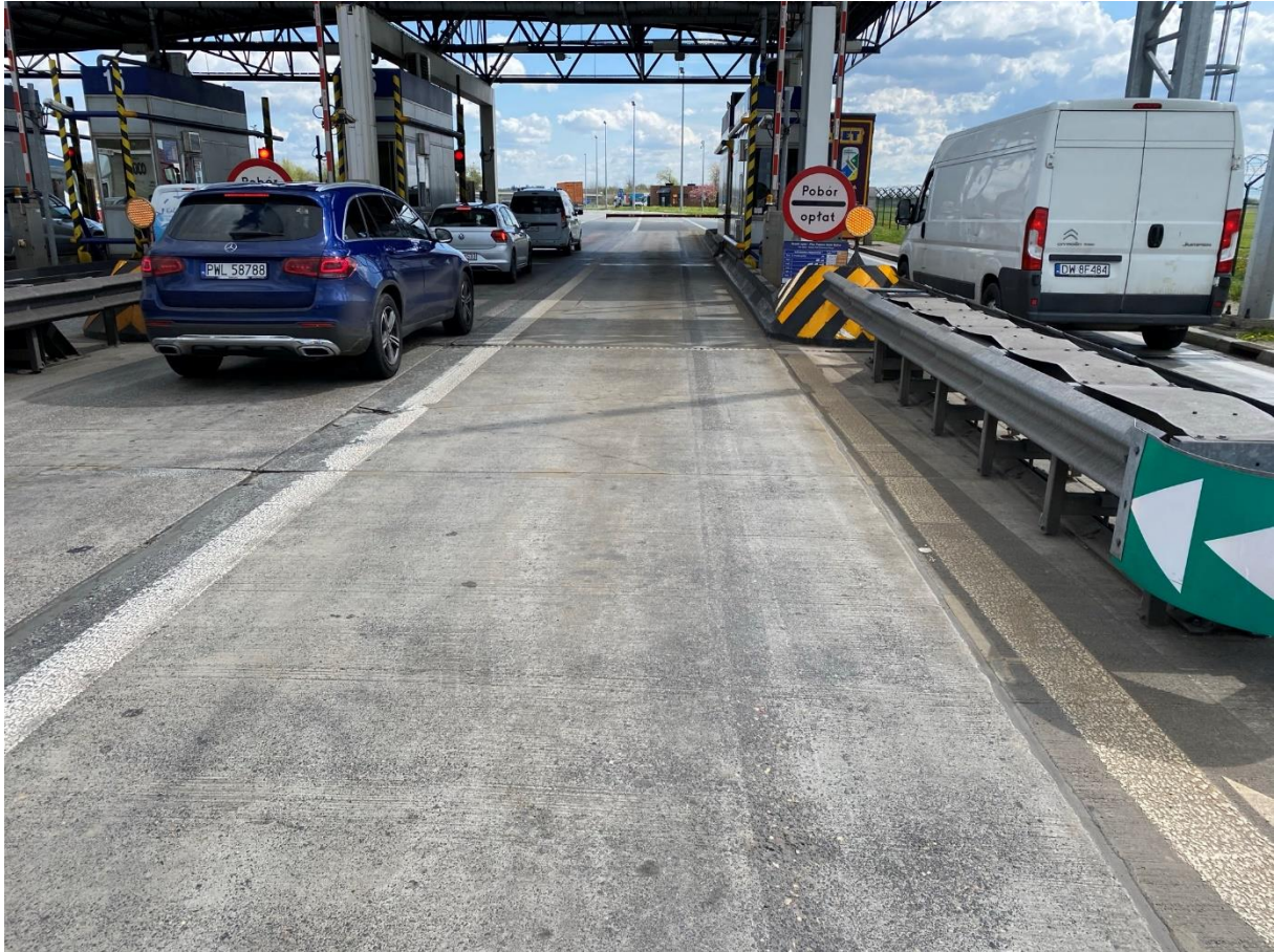
Zdj. 127 Widok ogólny nawierzchni betonowej na linii 17
