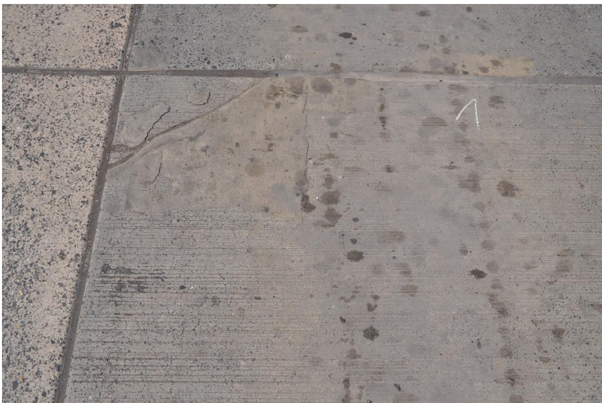
Zdj.13 Rozszczelnienie szczeliny podłużnej w nawierzchni betonowej w ścieżce przejazdu kół.
