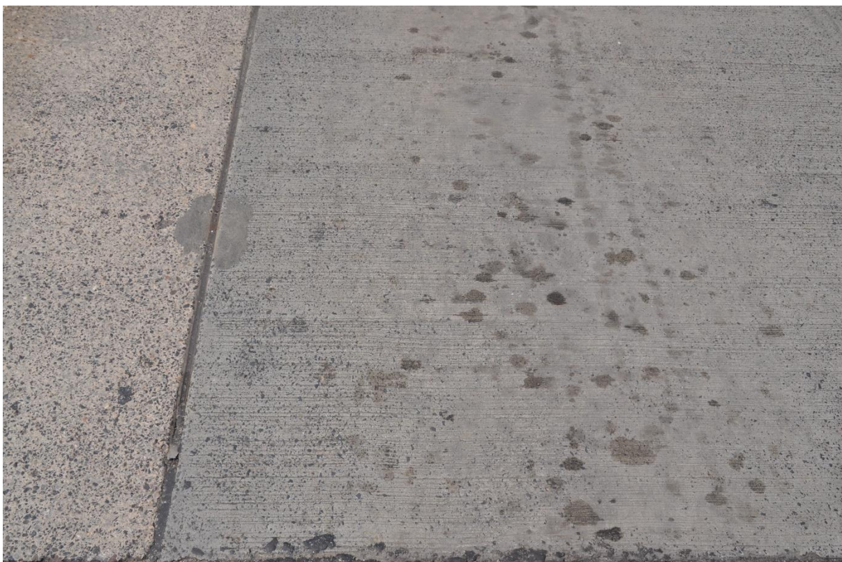
Zdj.13 Rozszczelnienie szczeliny podłużnej w nawierzchni betonowej w ścieżce przejazdu kół.
