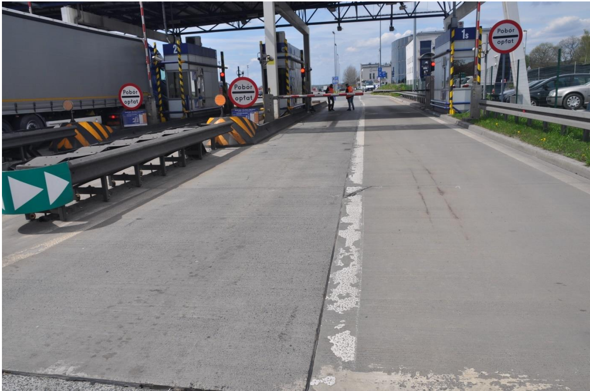
Zdj. 6 Widok ogólny nawierzchni betonowej na linii 1
