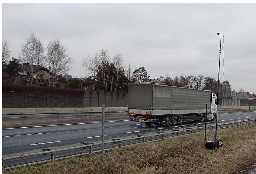
Fot. 3.1. Widok autostrady A4 z najbliższym otoczeniem – odcinek drogi zlokalizowany w m. Morawica w km 397+750
