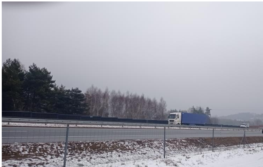
Fot. 3.1. Widok autostrady A4 z najbliższym otoczeniem – odcinek drogi zlokalizowany w m. Imielin w km 356+800
