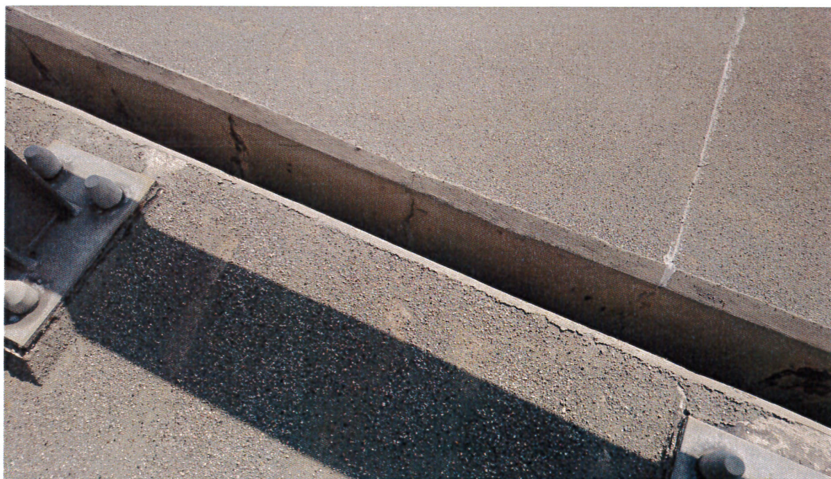
Zdj. 4. Obiekt M49P, M49L – gzyms w pasie rozdziału
