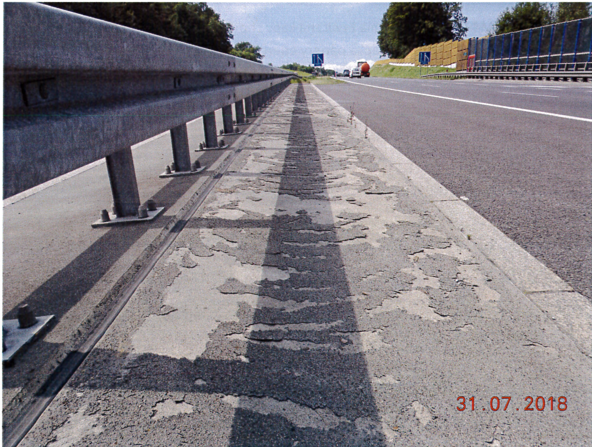
Zdj. 6. Obiekt M52L – nawierzchnia kapy chodnikowej wewnętrznej
