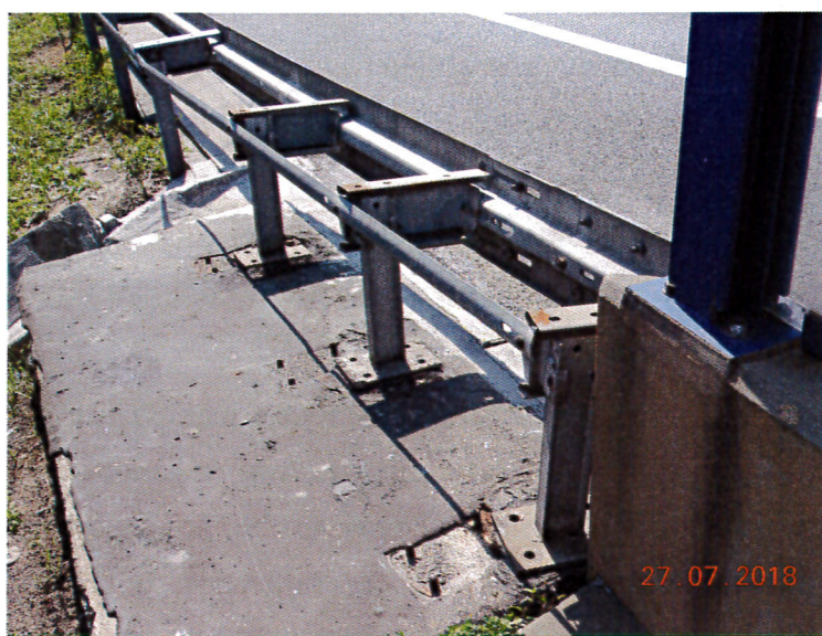
Zdj. 1. Obiekt M18L – nawierzchnia kapy chodnikowej zewnętrznej, bariera energochłonna
