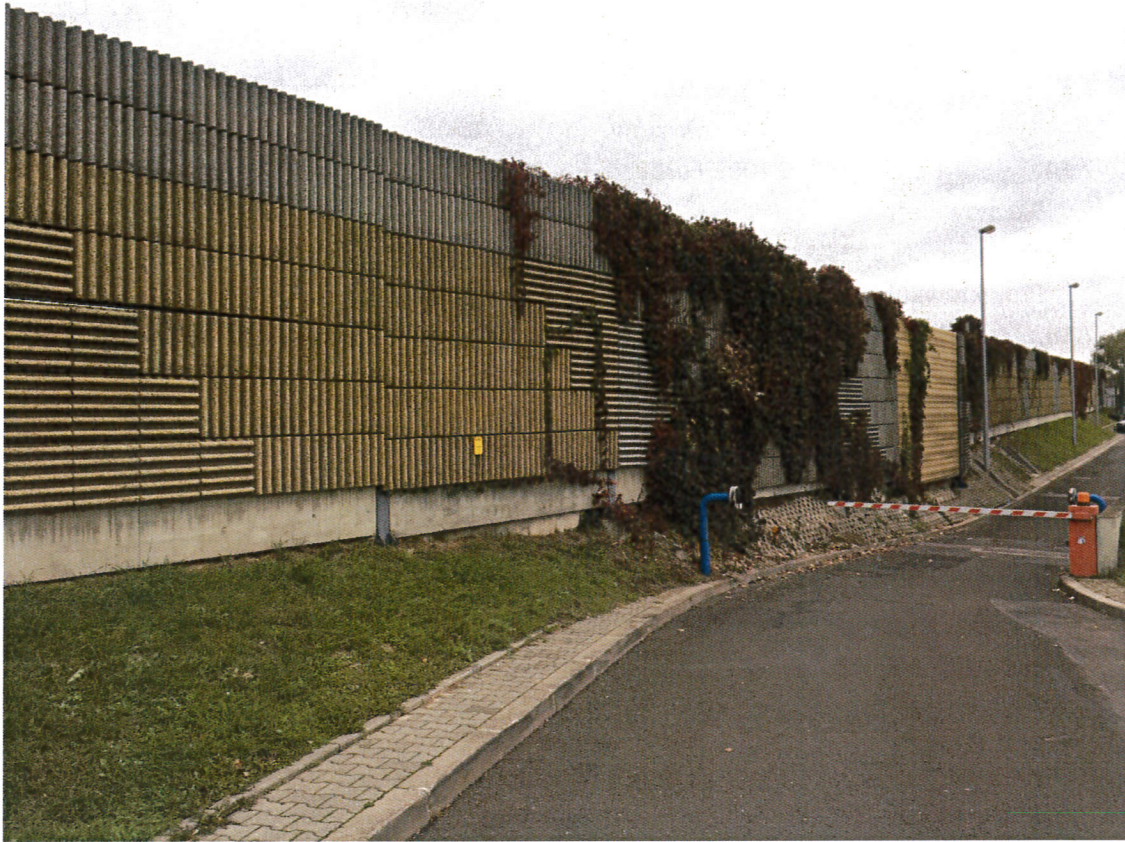
Fot.2. Widok na ekran akustyczny od strony autostrady w kierunku Katowic.
