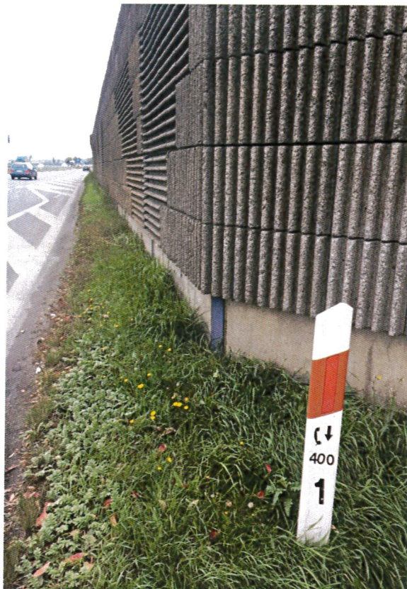
Fot.4. Widok na ekran akustyczny od strony autostrady w kierunku Katowic.
