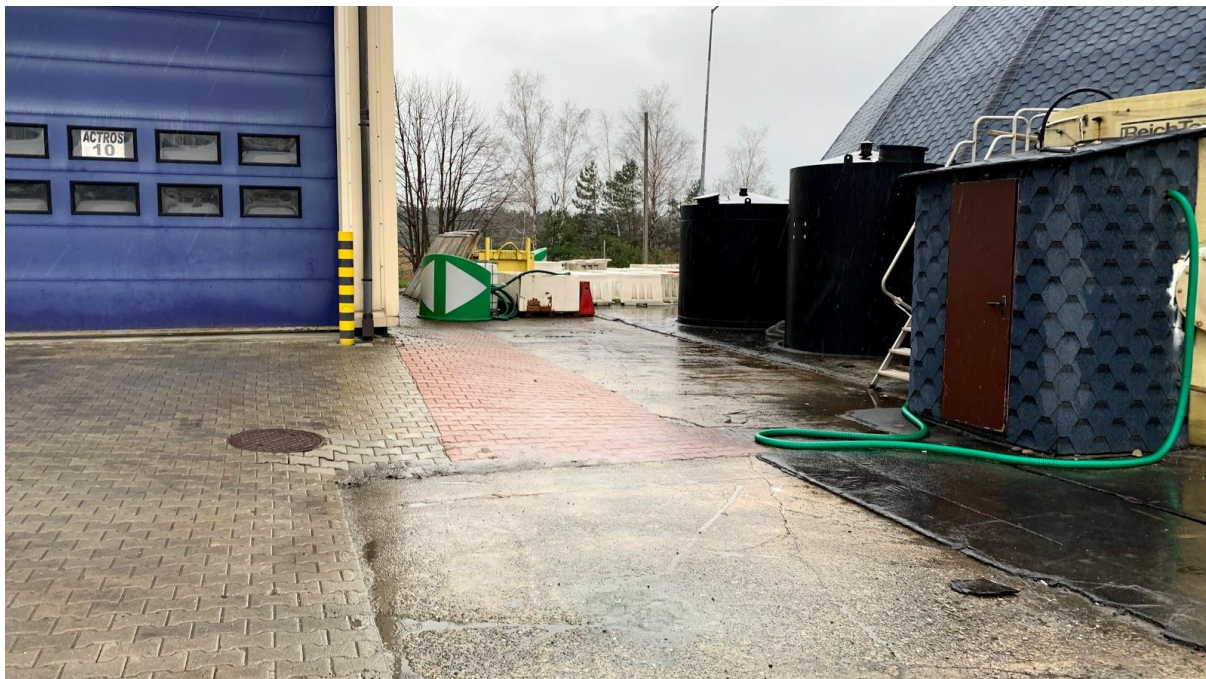
Fot. 12 Nawierzchnie przy magazynie soli
