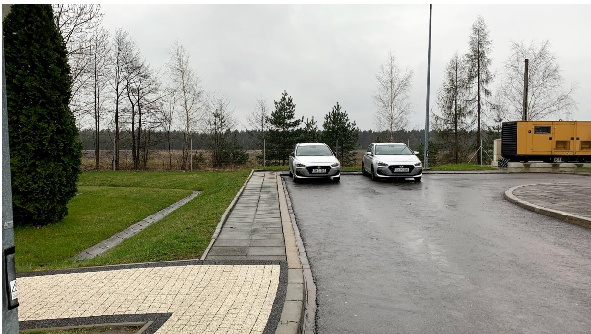
Fot. 20 Ściek przykrawężnikowy z betonowej kostki brukowej
