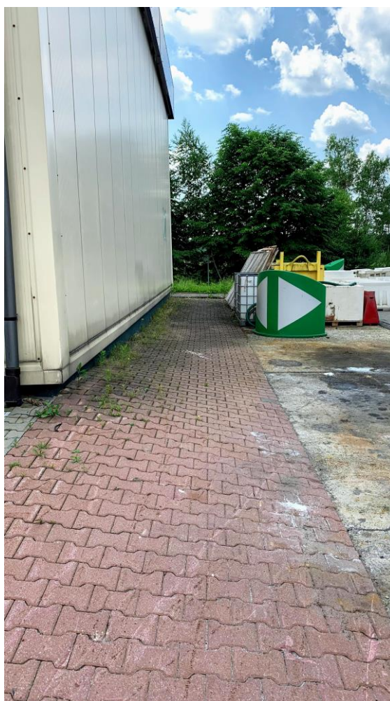
Fot. 9, 10 Chodnik z betonowej kostki brukowej za budynkiem garaży, przy magazynie soli
