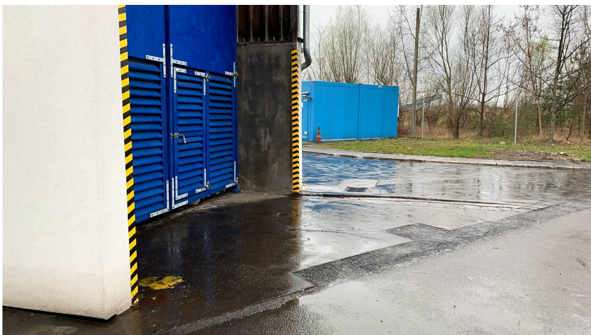
Fot. 13 Nawierzchnia asfaltowa przy magazynie soli
