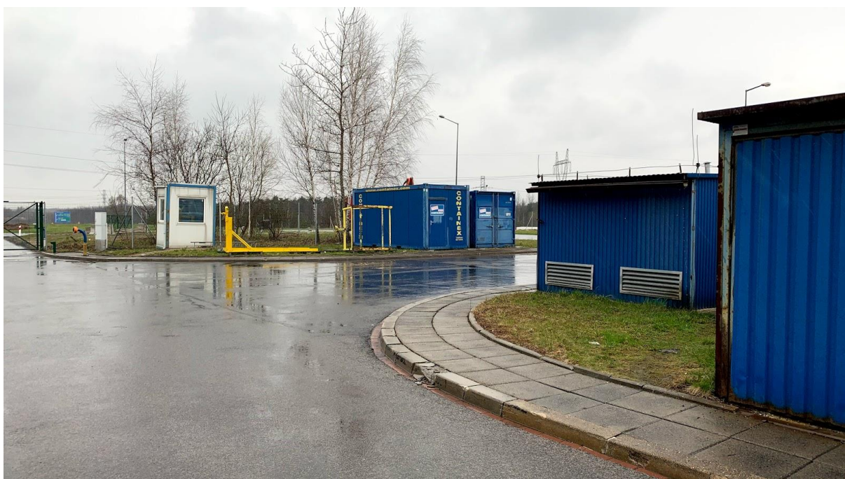
Fot. 8 Chodnik z płyt betonowych w centralnej części obwodu
