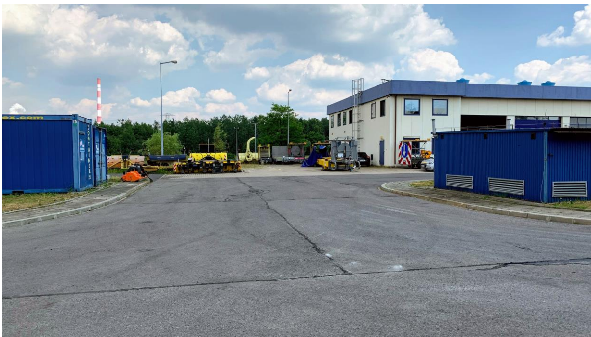
Fot. 2 Jezdnia o nawierzchni z betonu asfaltowego
