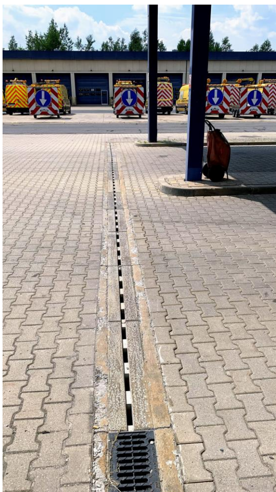
Fot. 21, 22 Odwodnienie liniowe żelbetowe szczelinowe
