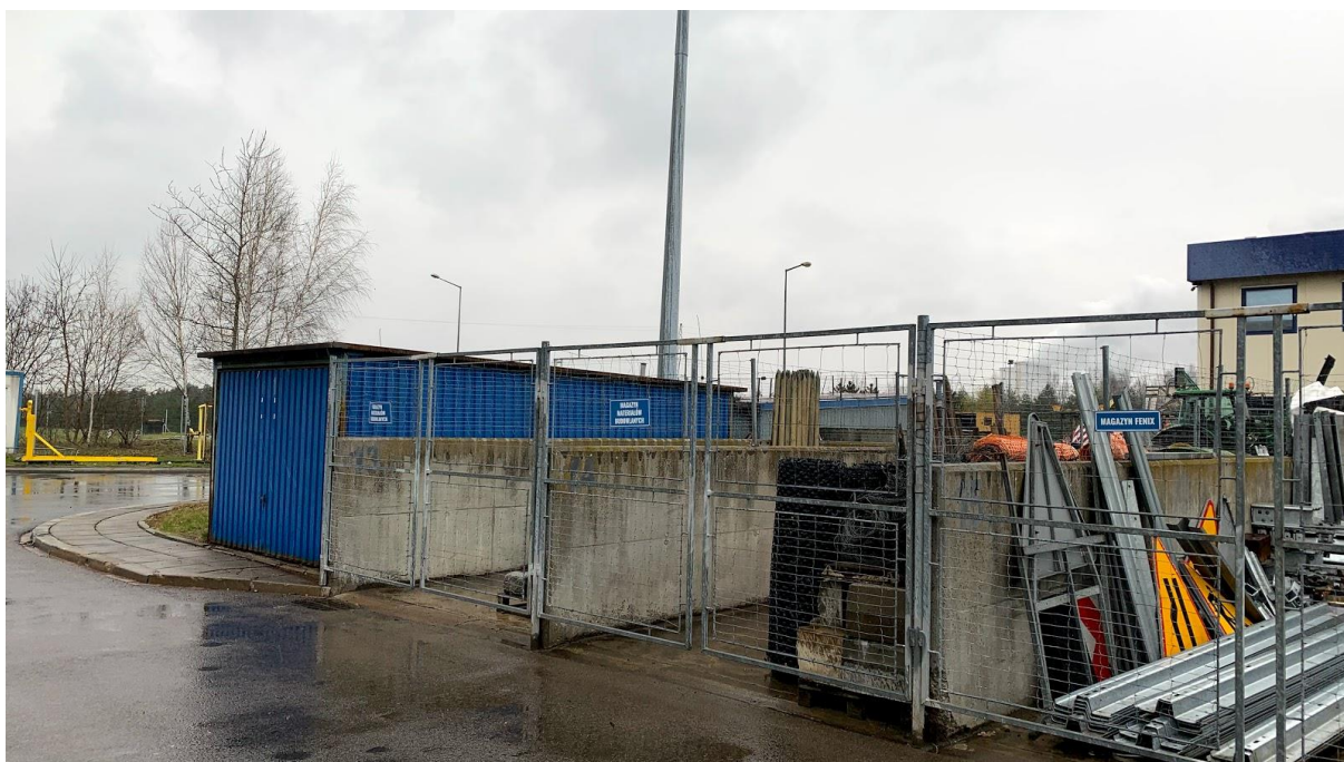
Fot. 19 Boksy na materiały budowlane
