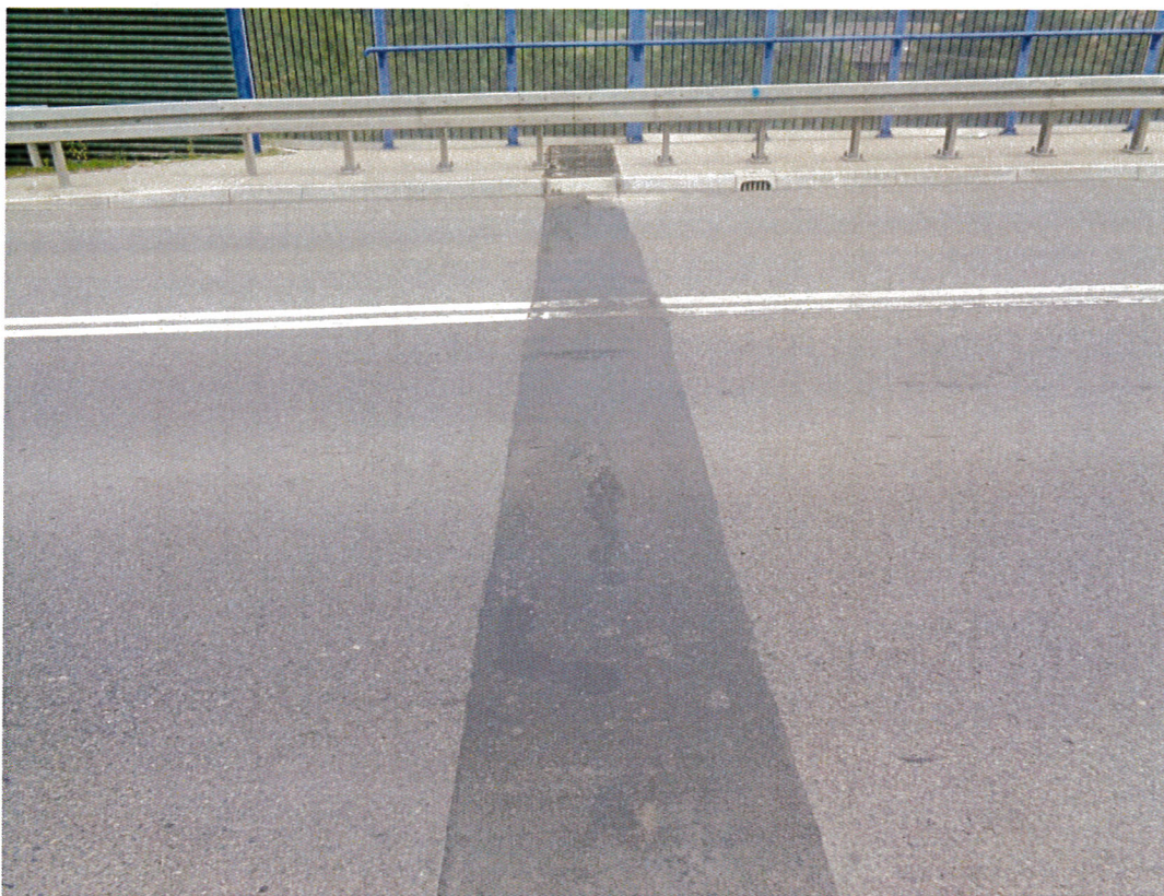
Zdj. 5. Obiekt M26 – przekrycie dylatacyjne nad przyczółkiem od strony północnej
