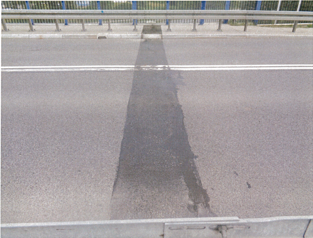
Zdj. 3. Obiekt M26 – przekrycie dylatacyjne nad przyczółkiem od strony południowej
