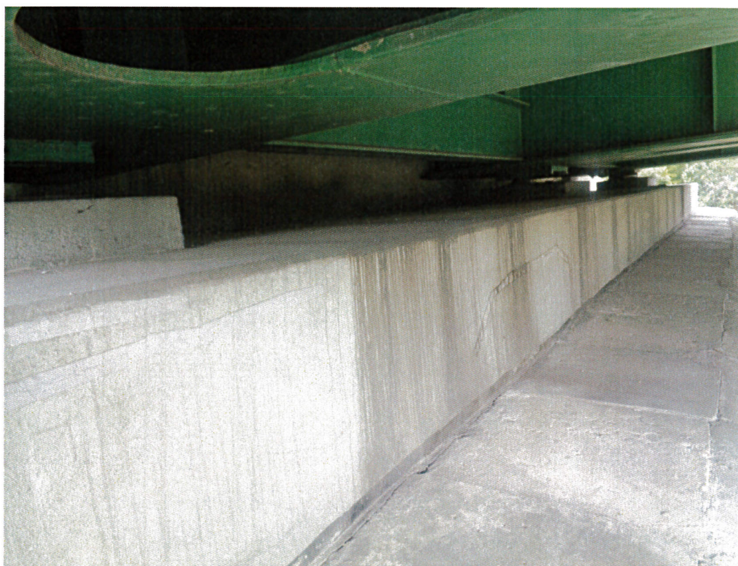
Zdj. 6. Obiekt 26 – przyczółek północny
