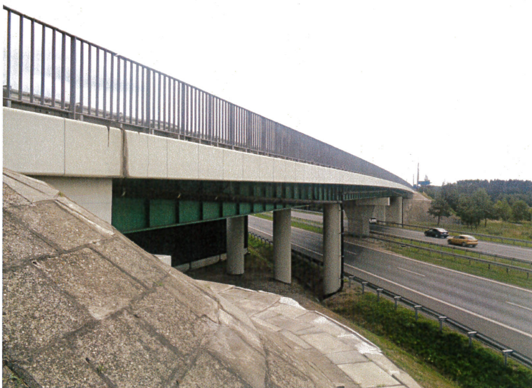
Zdj. 2. Obiekt M26 – widok od strony przyczółka północnego
