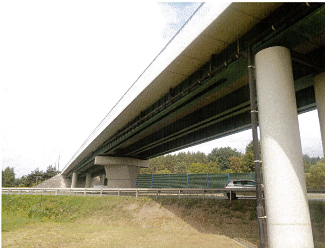
Zdj. 1. Obiekt M26 – widok od strony przyczółka południowego
