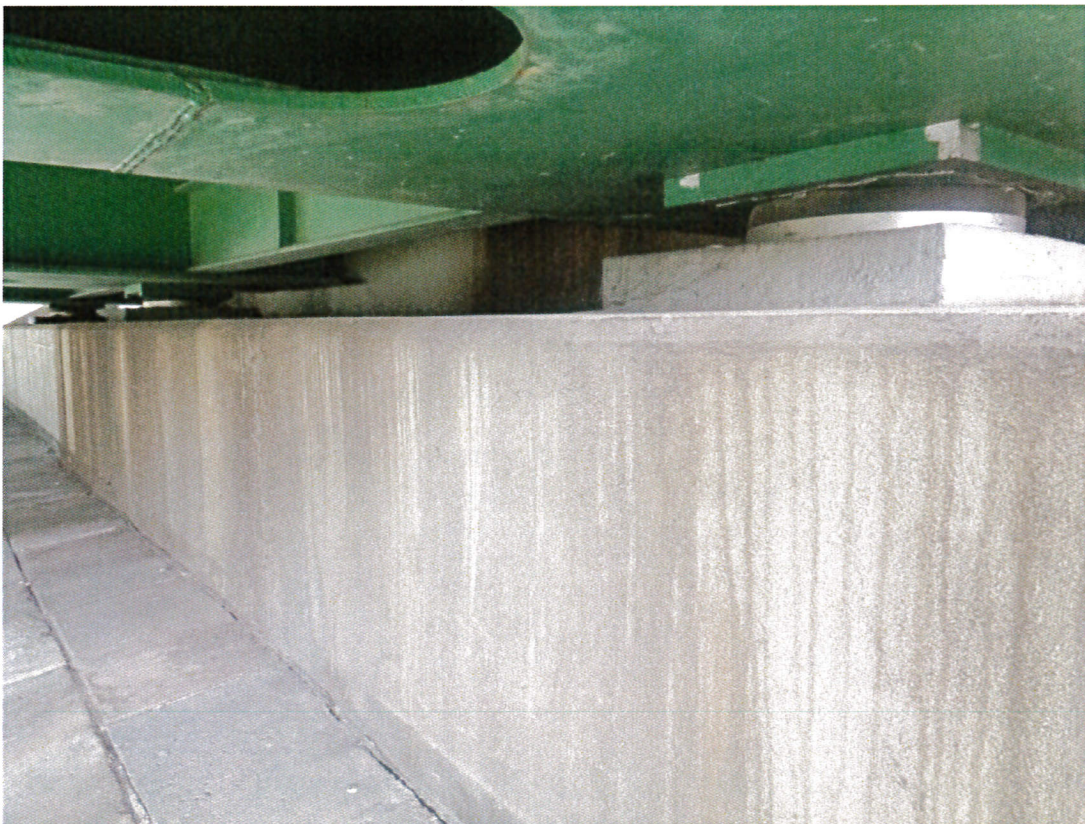
Zdj. 4. Obiekt M26 – przyczółek południowy
