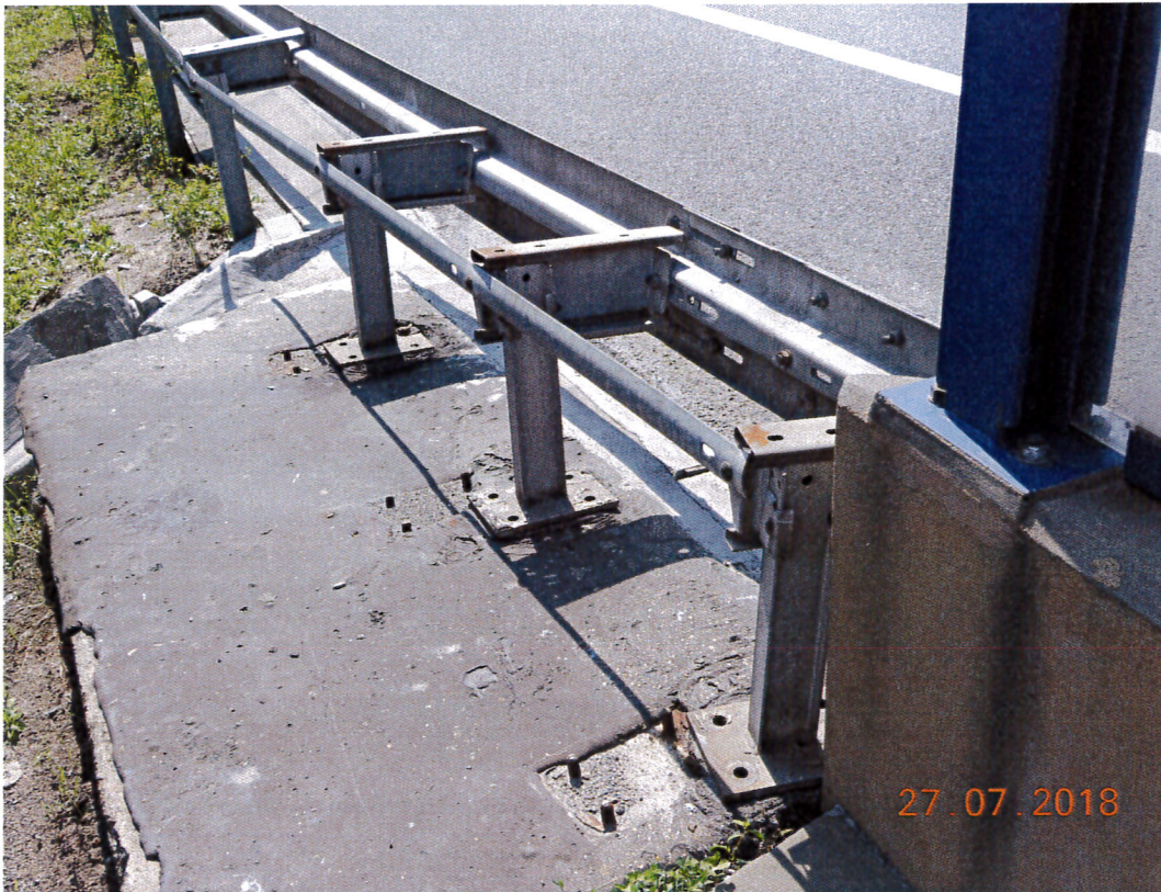
Zdj. 3. Obiekt M18L – nawierzchnia kapy chodnikowej zewnętrznej, bariera energochłonna
