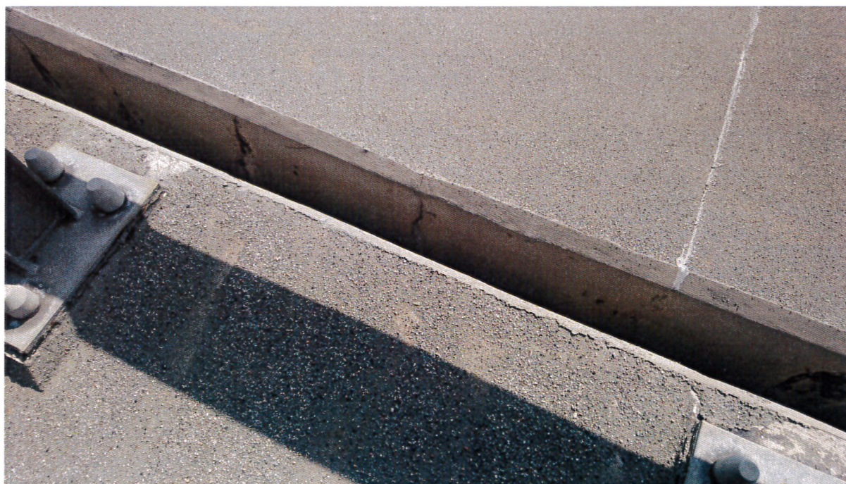
Zdj. 6. Obiekt M49P, M49L – gzyms w pasie rozdziału
