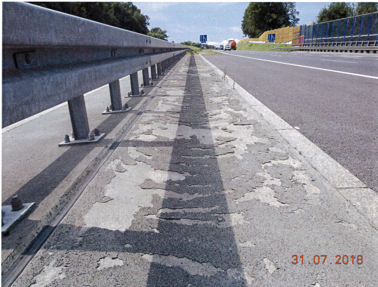
Zdj. 8. Obiekt M52L – nawierzchnia kapy chodnikowej wewnętrznej
