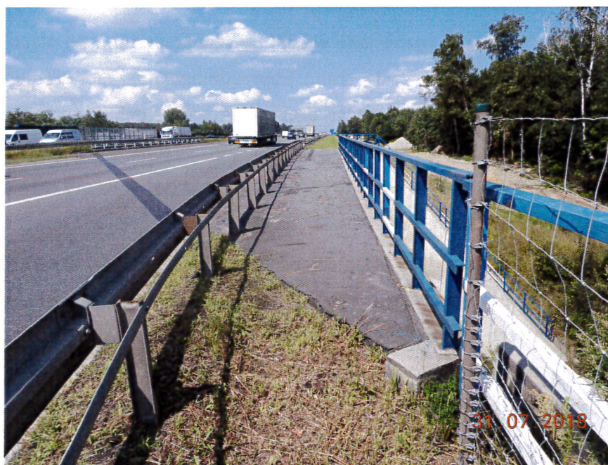
Zdj. 1. Obiekt M12L – nawierzchnia kapy chodnikowej zewnętrznej
