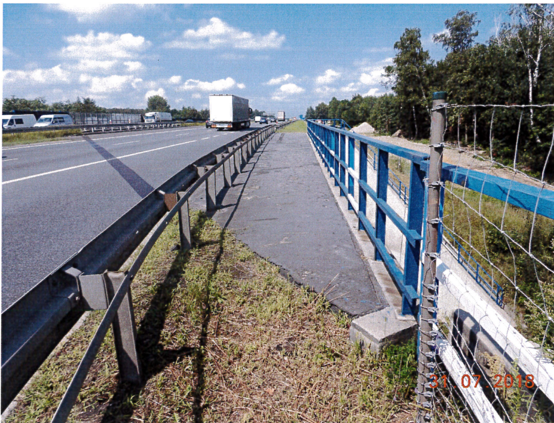
Zdj. 6. Obiekt M12L – widok na kapę chodnikowa zewnętrzną (północną)
