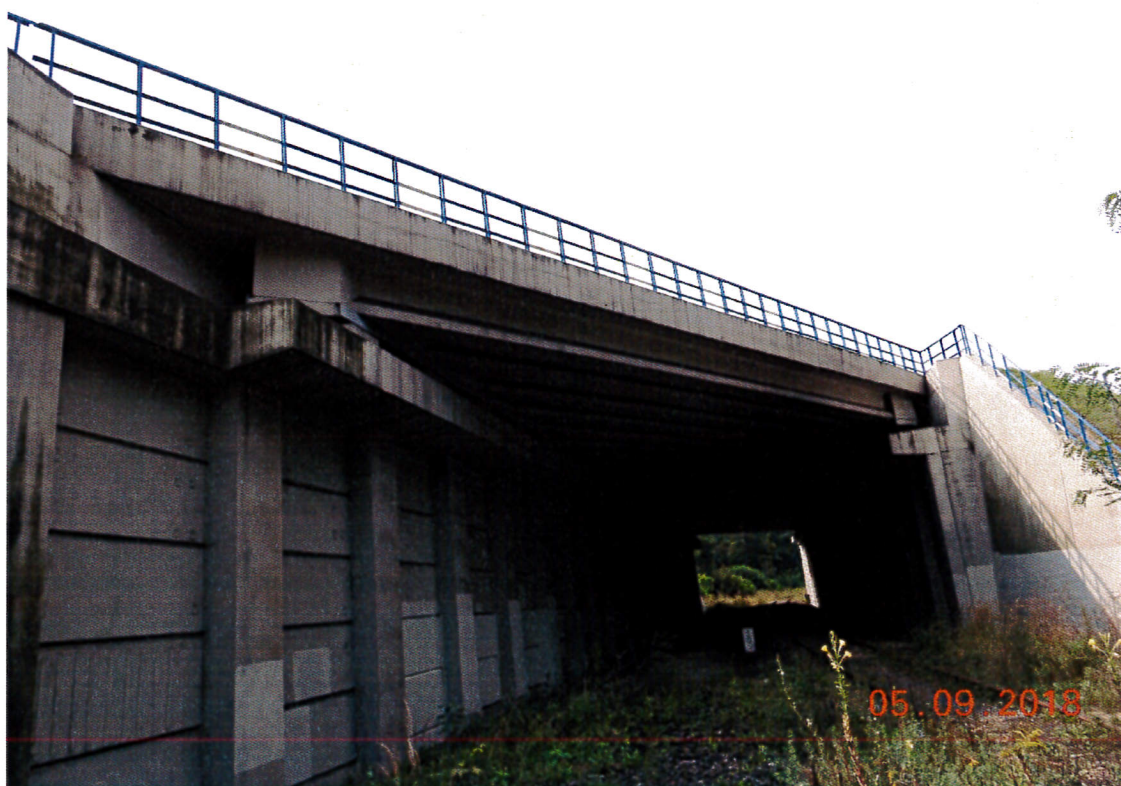
Zdj. 7. Obiekt M12L – widok na gzyms zewnętrzny
