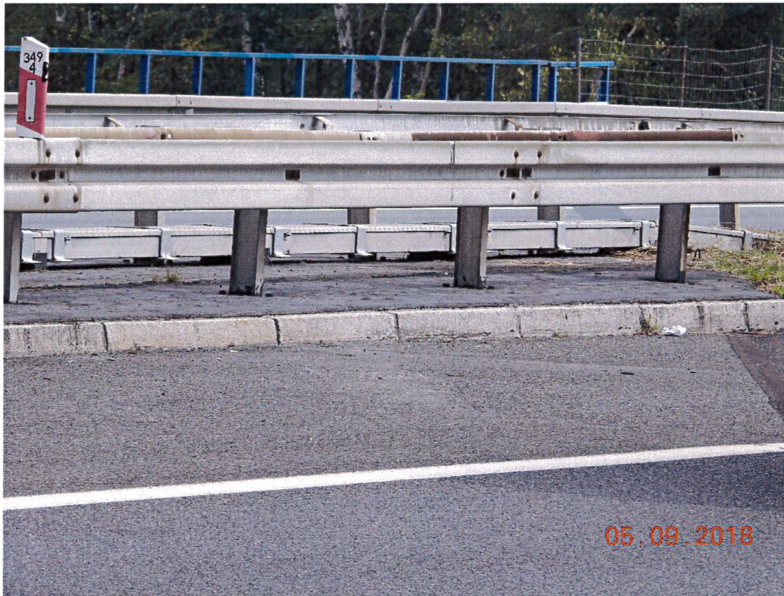
Zdj. 4. Obiekt M12P – widok na kapę chodnikową w pasie rozdziału
