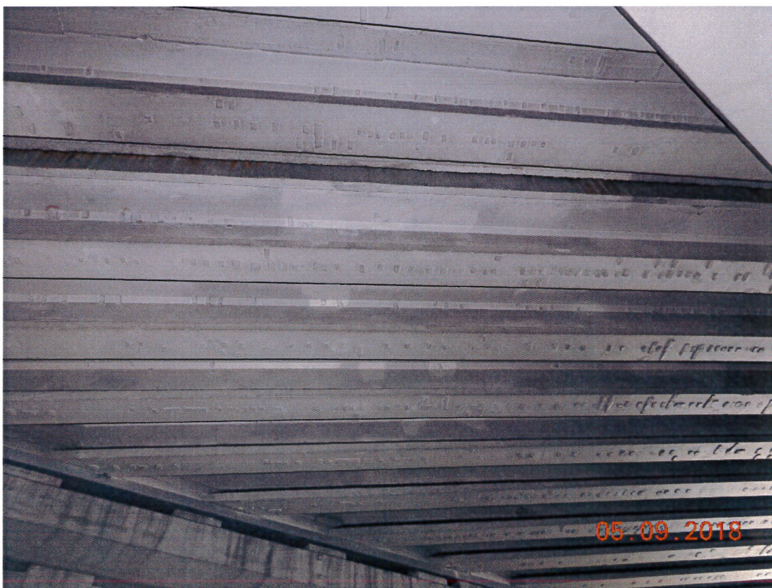
Zdj. 5. Obiekt M12P, M12L – widok na gzyms w pasie rozdziału
