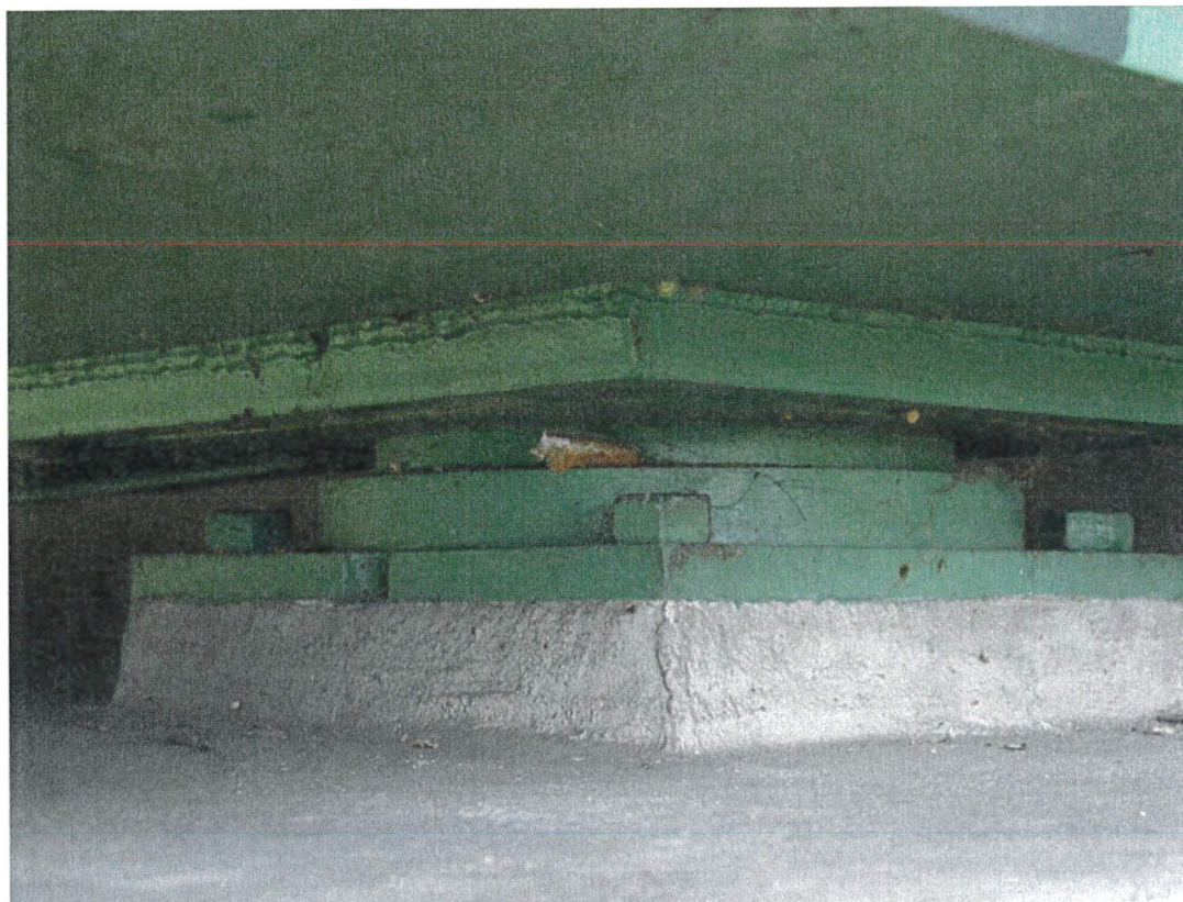
Zdj. 1. Obiekt M24 – łożysko soczewkowe ŁA1. Ze względu na wyciśnięty arkusz PTFE łożysko przeznaczone jest do wymiany
