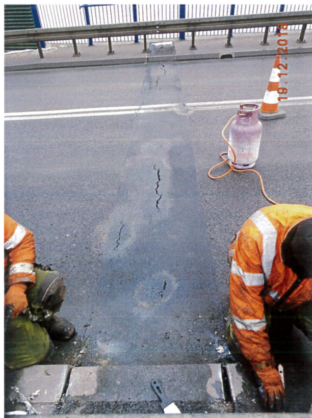
Zdj. 2. Urządzenie dylatacyjne od strony północnej w trakcie napraw w grudniu 2018 r.
