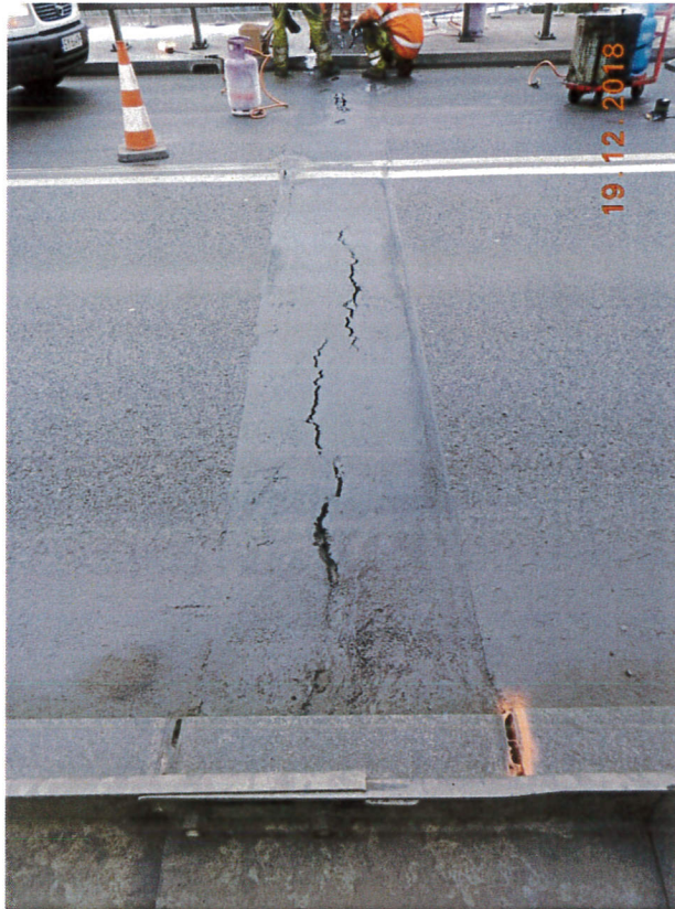
Zdj. 1. Urządzenie dylatacyjne od strony północnej w trakcie napraw w grudniu 2018 r.
