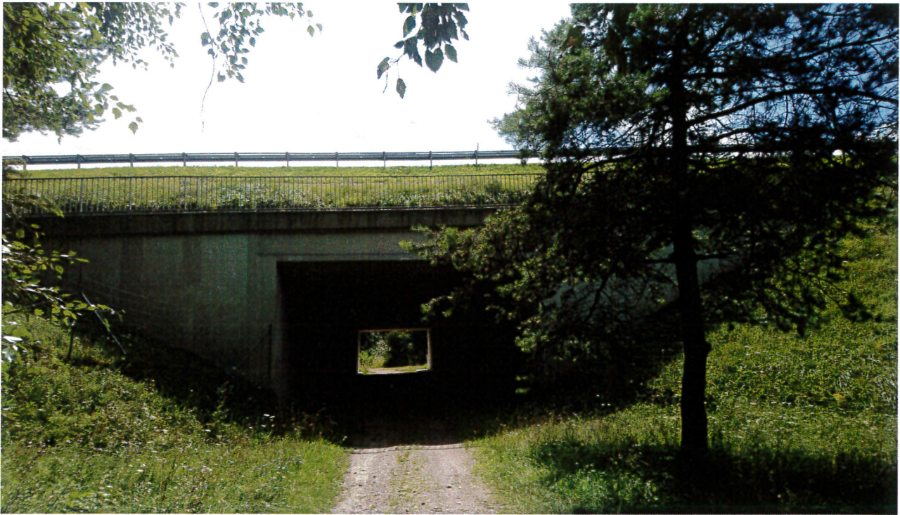
Zdj. 5. Obiekt M47 – wlot od strony północnej
