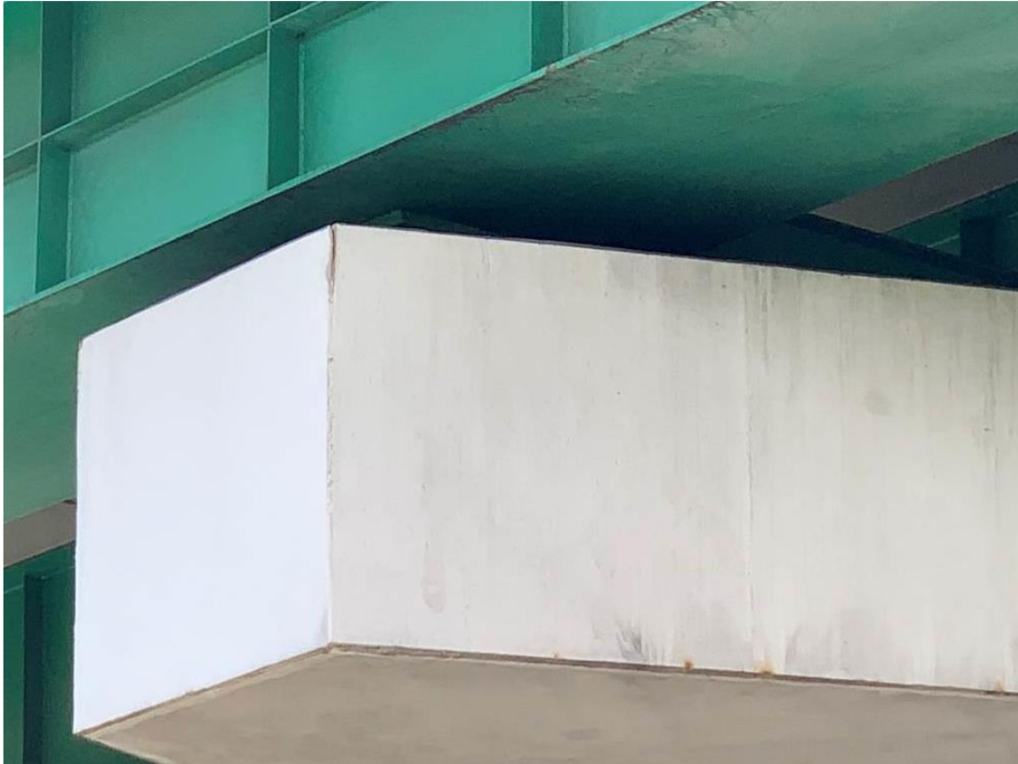
Zdj. 7. Obiekt M26 – stalowy płaszcz podpory pośredniej
