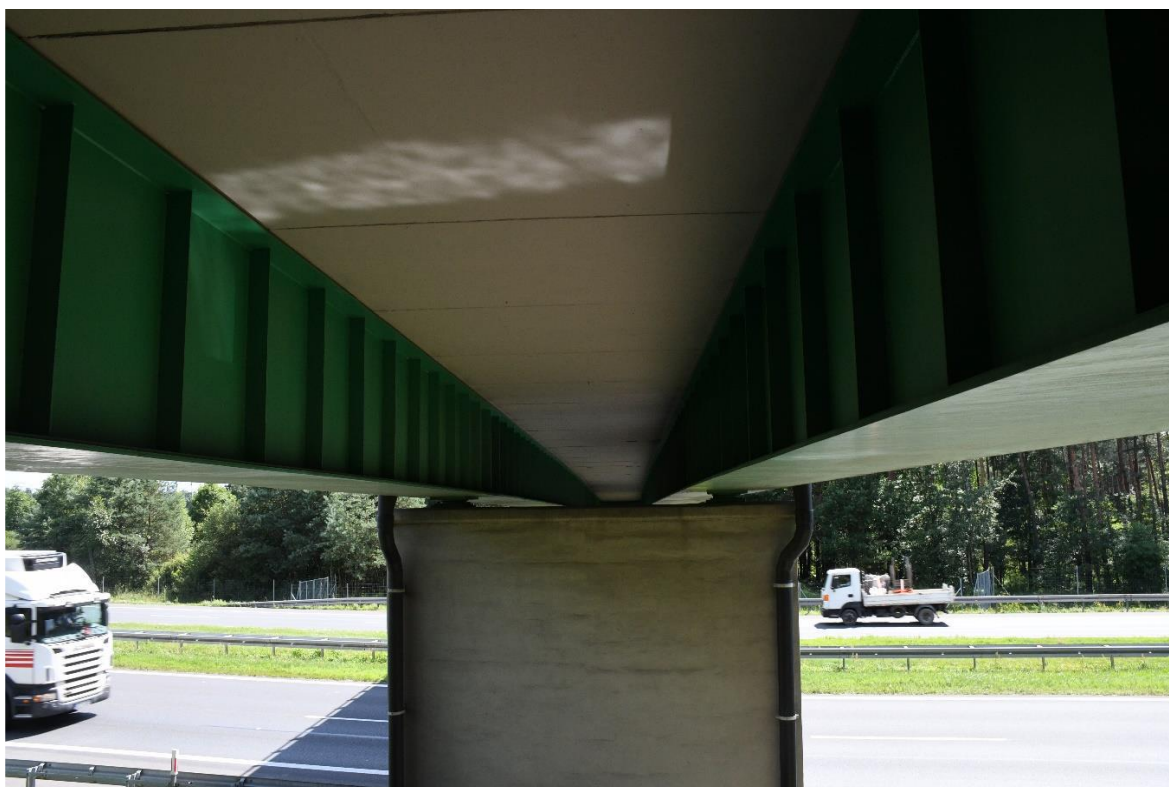
Zdj. 3. Obiekt M24 – widok na spód konstrukcji ustroju nośnego
