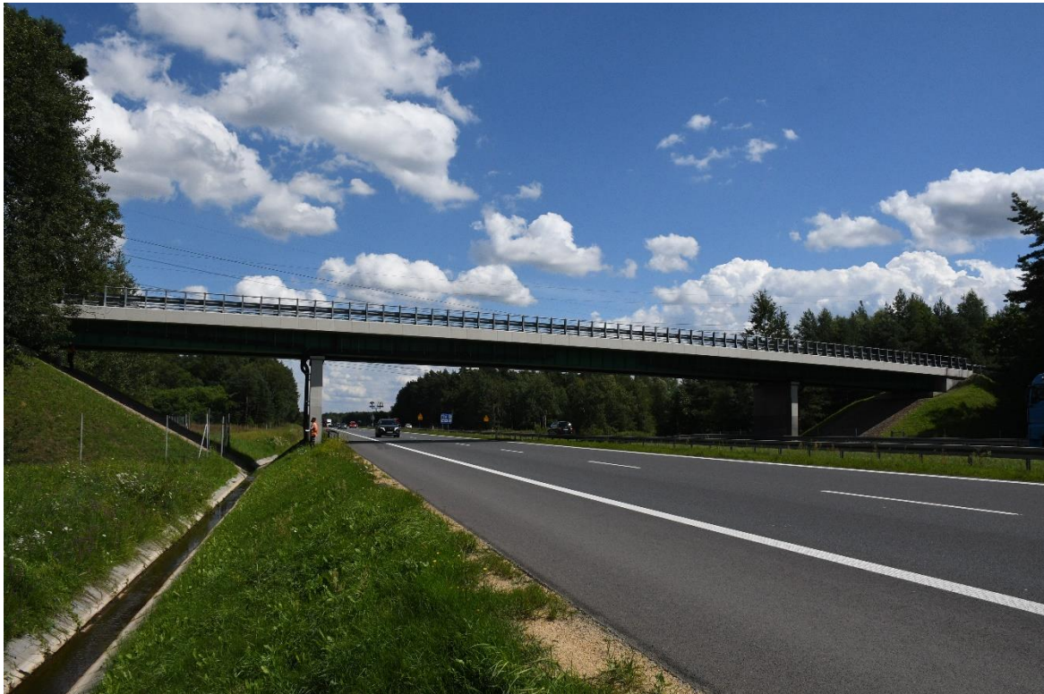
Zdj. 1. Widok z boku obiektu mostowego M24
