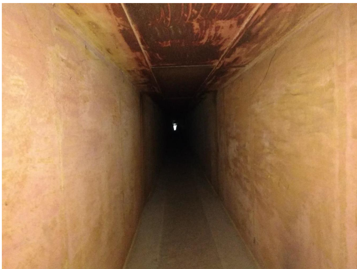
Zdj. 4. Obiekt M24 – wnętrze dźwigara od strony Katowic
