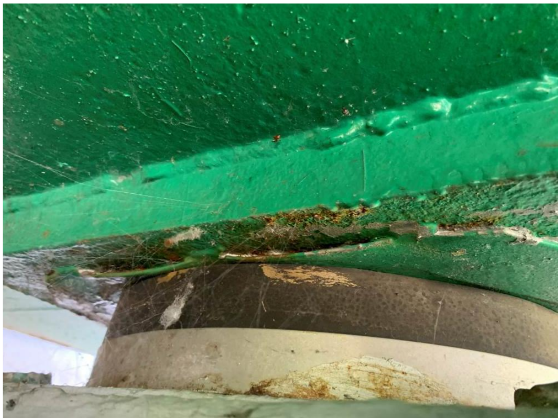
Zdj. 8. Obiekt M26 – łożysko mostowe
