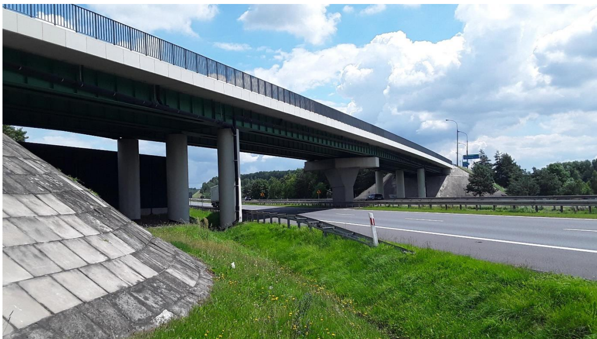
Zdj. 2. Widok z boku obiektu mostowego M26
