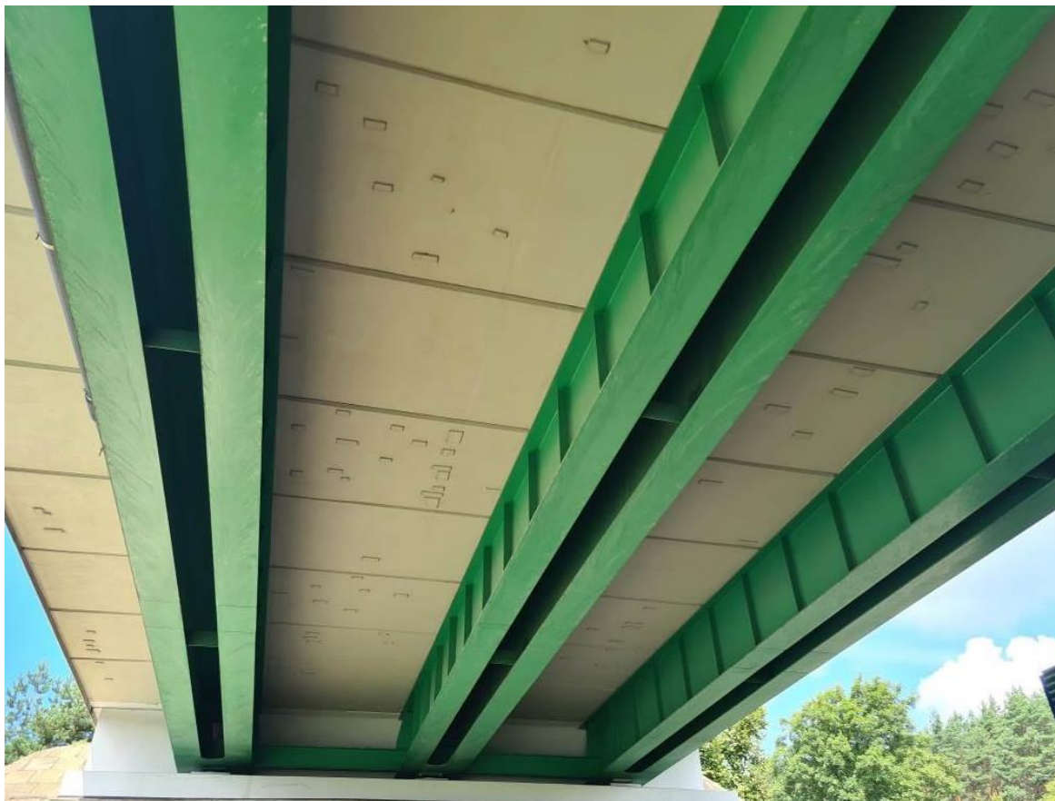
Zdj. 6. Obiekt M26 – widok na spód konstrukcji ustroju nośnego
